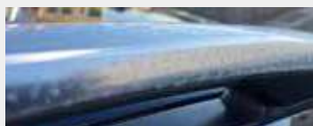
未施工：白サビが発生し美観を損ねている
